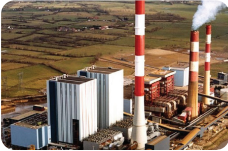
Centrale électrique au charbon
